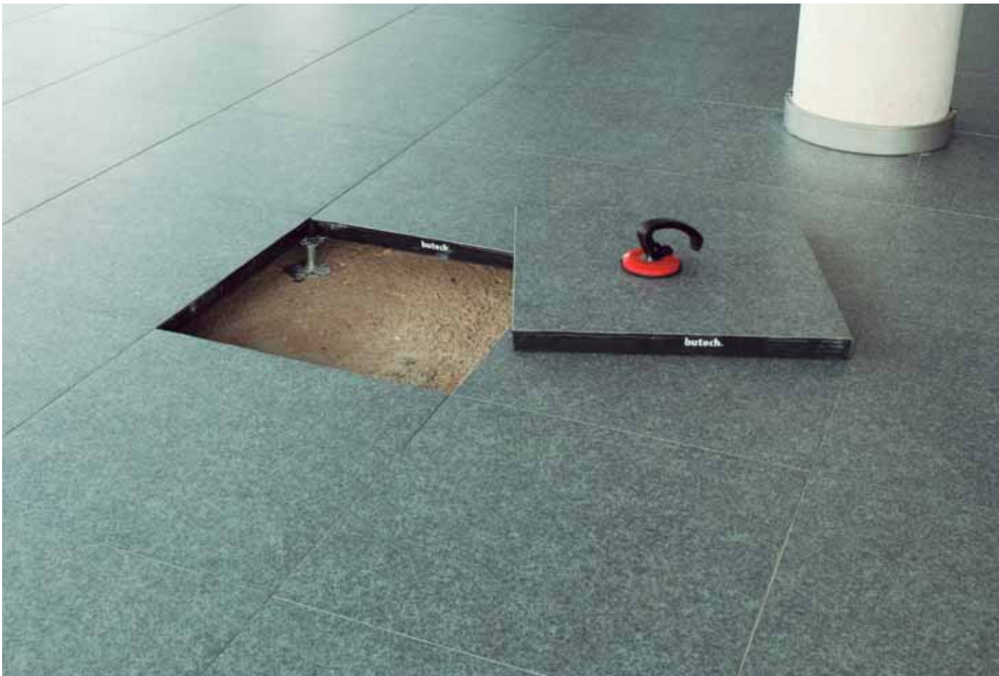
Edificio tecnológico Universidad Jaime I (Castellón, Spain)
