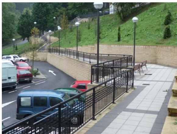
El diseño del bloque con el centro hueco y la comodidad de construcción sin mortero permite que el agua desagüe libremente desde la parte trasera de la pared. Se crea un área vertical de desagüe tras el bloque. Esta área de drenaje está formada por una capa de grava, colocada detrás de los bloques y dentro de los mismos. Este sistema de drenaje incorporado en el diseño del bloque evita cualquier acumulación de presión hidrostática.
