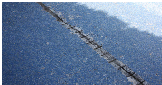
Foto: reparación de grietas previa aplicación DRY120
