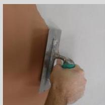
**weber.cal flexible** se aplica en un mínimo de dos manos. Aplicar una primera mano que servirá para dar el espesor a la aplicación extendiendo el producto en trazos largos sobre la base sin detenerse a realizar repasos. Las juntas de trabajo se pueden realizar con cinta adhesiva.
