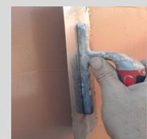
Si fuese necesario se aplicará una nueva capa de material para obtener el acabado fino sedoso. No realizar repasos una vez el producto haya secado. En colores intensos pueden aparecer aguas claro-oscuros inherentes a los estucos minerales.
