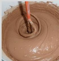
Amasar **weber.cal flexible** con 1,6-1,8 l de agua limpia por bolsa, a batidor eléctrico, hasta obtener una masa fina, untuosa al tacto y exenta de grumos.
