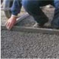
Verter la mezcla sobre la superficie y reglear con un espesor mínimo de 3 cm. Dejar fraguar un mínimo de 12 horas en condiciones normales, antes de ser revestido.
