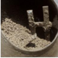
Introducir **weber.floor light mix** en la hormigonera (o máquina de bombeo), añadir 4 litros de agua por saco y mezclar durante unos 3 minutos, hasta obtener una pasta homogénea de tonalidad gris brillante.
